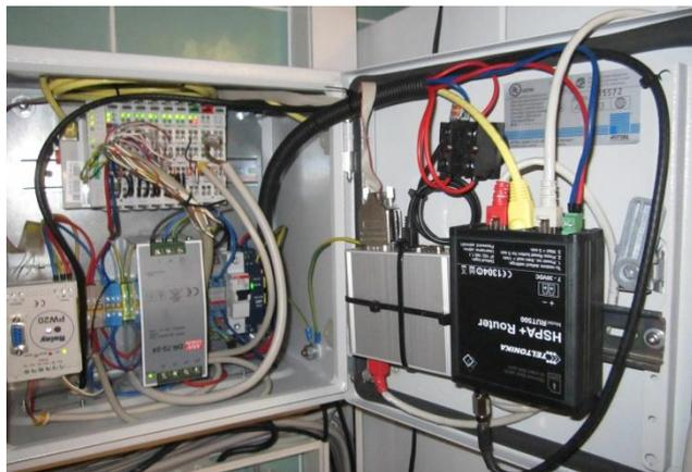
Abbildung 9: Messdatenerfassungssystem bei Untersuchung der Lastflexibilität von Wärmepumpen
